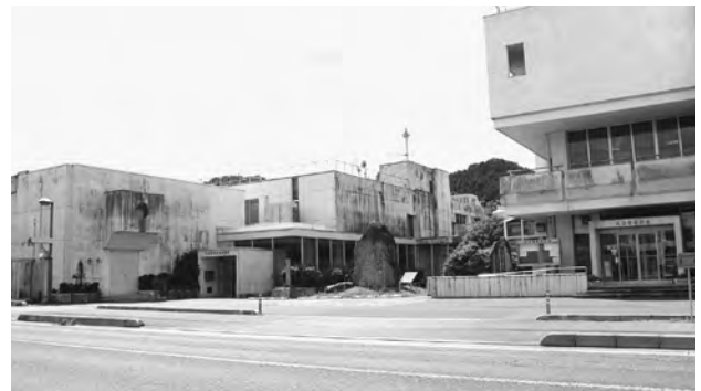
建て替えを検討している公民館と庁舎
