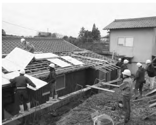
屋根の改修作業
