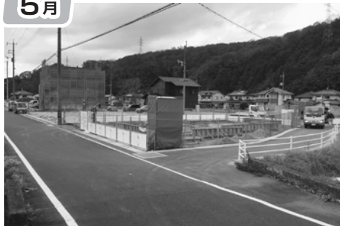
完成した分譲地で住宅の建築が進む
