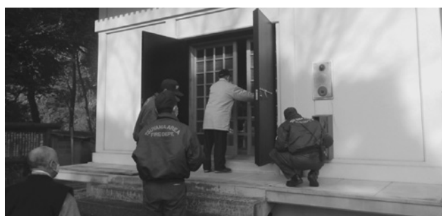
佛教寺での消火器の設置確認
