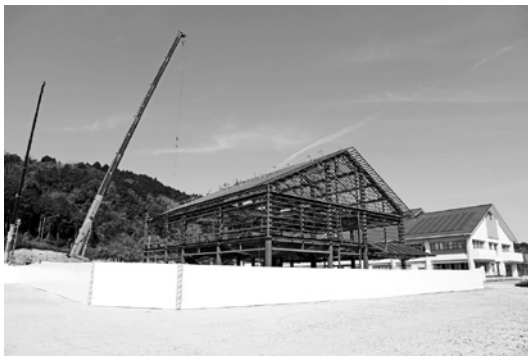
令和9年4月開校に向けて 建設工事が進む新小学校校舎
