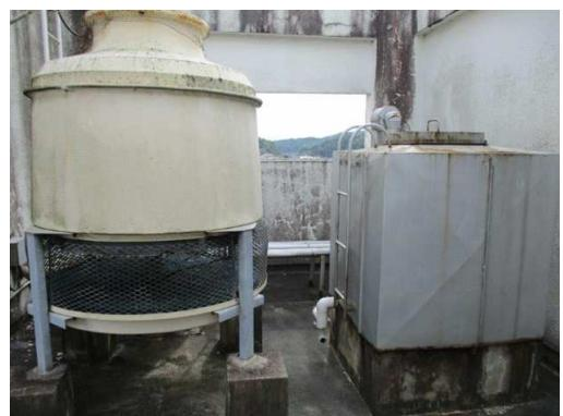
冷却塔・膨張タンクの老朽化
