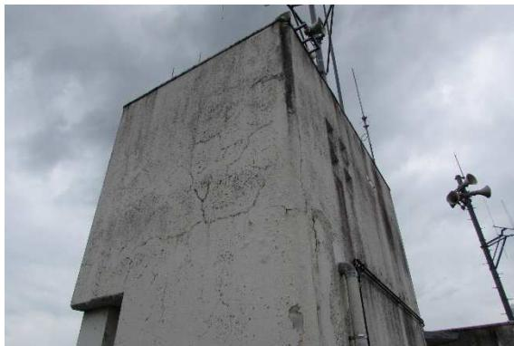
塔屋仕上げ塗装の劣化
