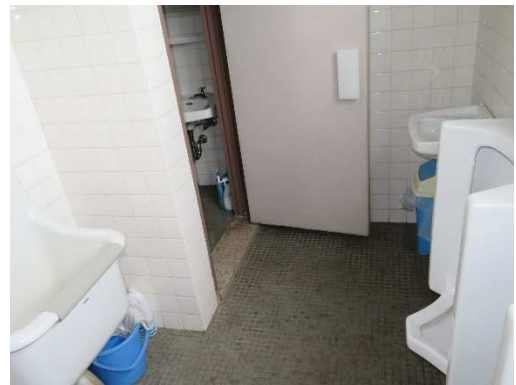
庁舎2階トイレ
