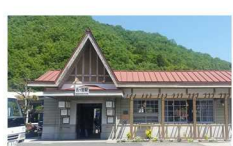
⑫旧片上鉄道 吉ヶ原駅舎 [久米郡美咲町 吉ヶ原432-1]
